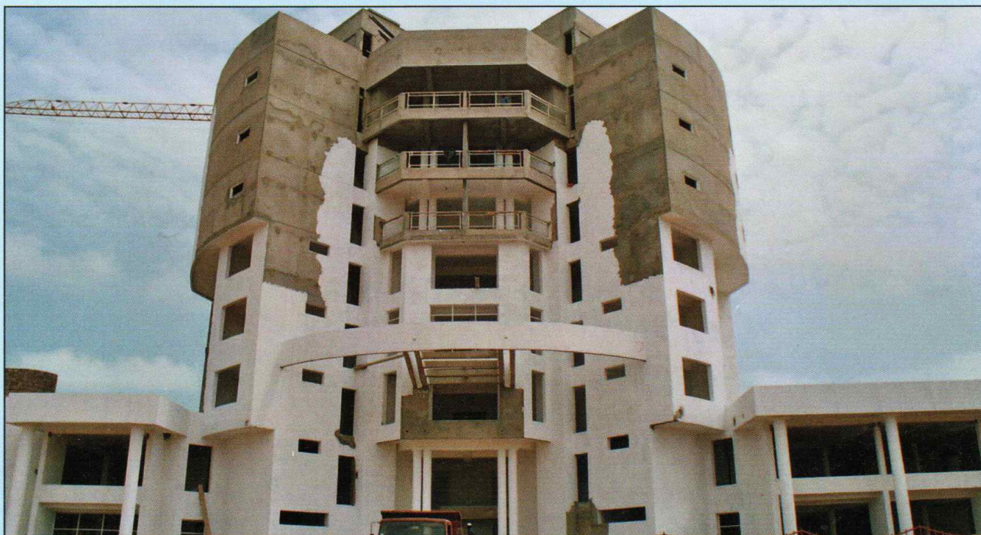
SIEGE DE FUTURELEC GAMBIA LTD EN CONSTRUCTION
