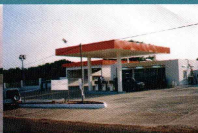
Station service Barlandé à Boké
