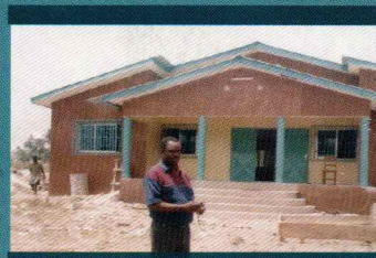
Centre santé réalisé par la Fondation
