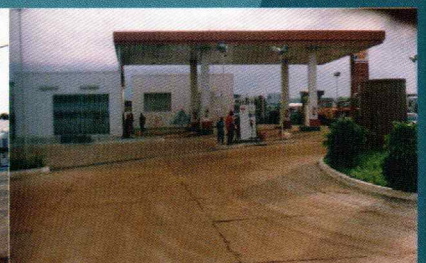
Station service Kagbelen à Dubreka
